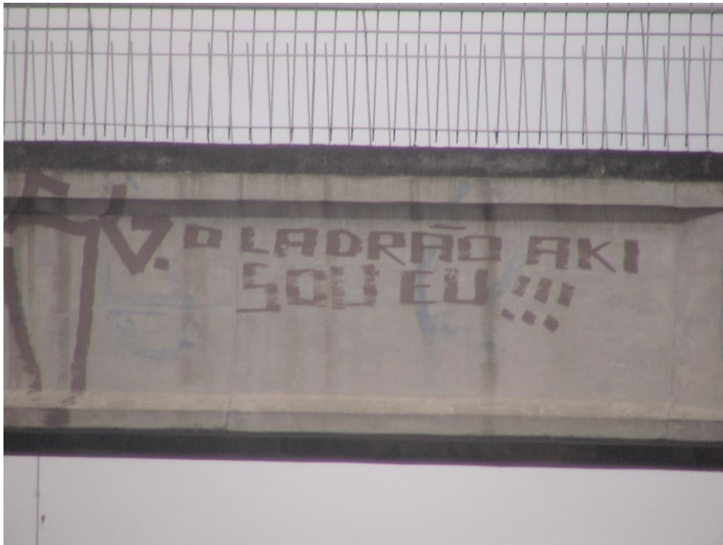
Figura 2. Passarela sobre a Rodovia Fernão Dias junto à Rua General Jerônimo Furtado, sentido São Paulo, registrada em 14 de junho de 2012. Fonte: arquivo pessoal do autor
