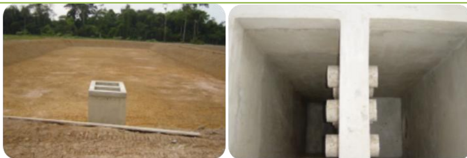
Figura 4 – Caixa de nível ou monge utilizado na piscicultura para escoamento da água do viveiro.
